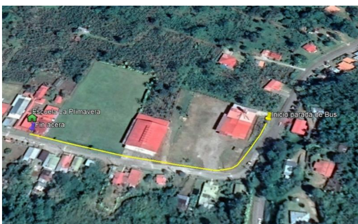
Imagen 5. Acera a construir marcada en amarillo.
