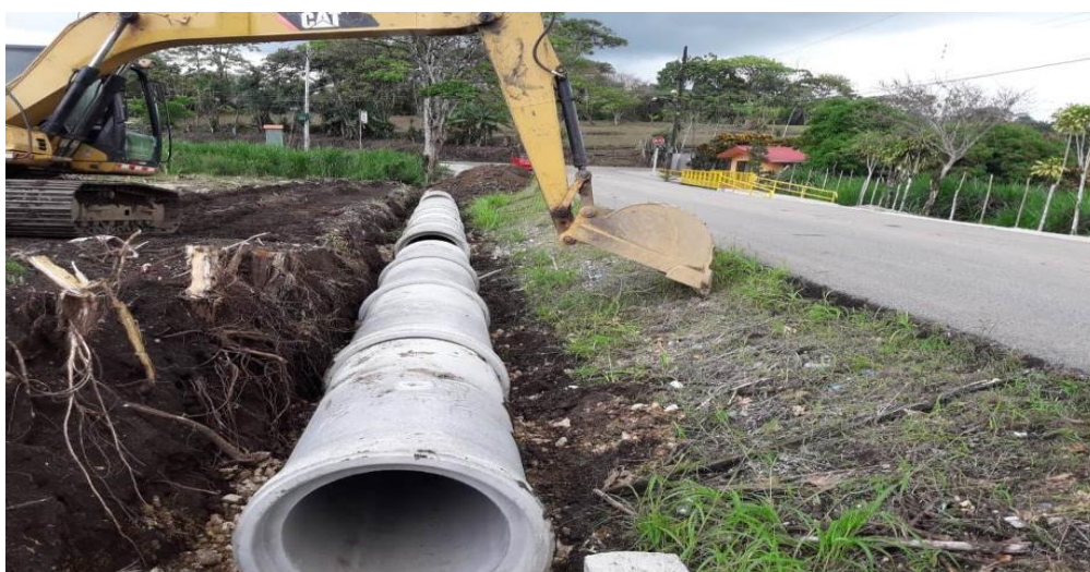
Imagen 3. Obras realizadas en San Joaquín.
