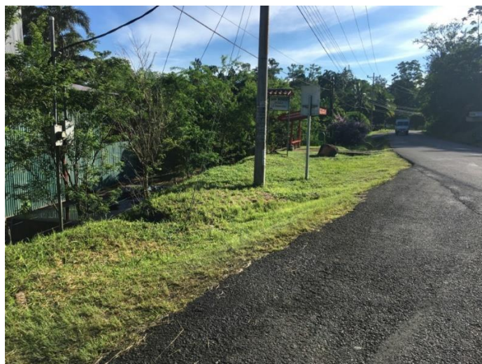
Imagen 6. Tramo de acera a construir.
